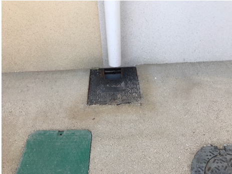
1 1245 Raccorder descente EP au regard
