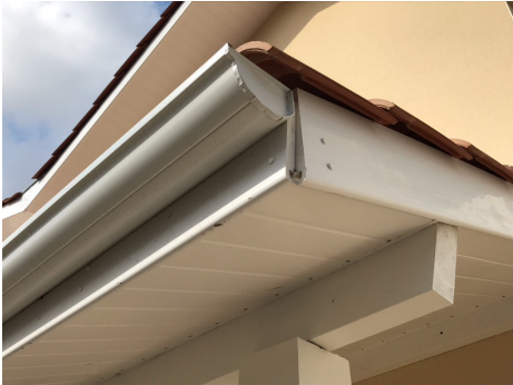
3 1544 Manque abouts sur bandeaux de rive (x2)
